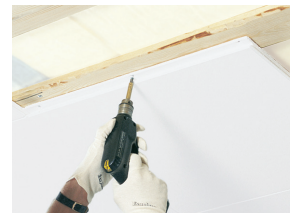
Монтаж Focus F с саморезами
